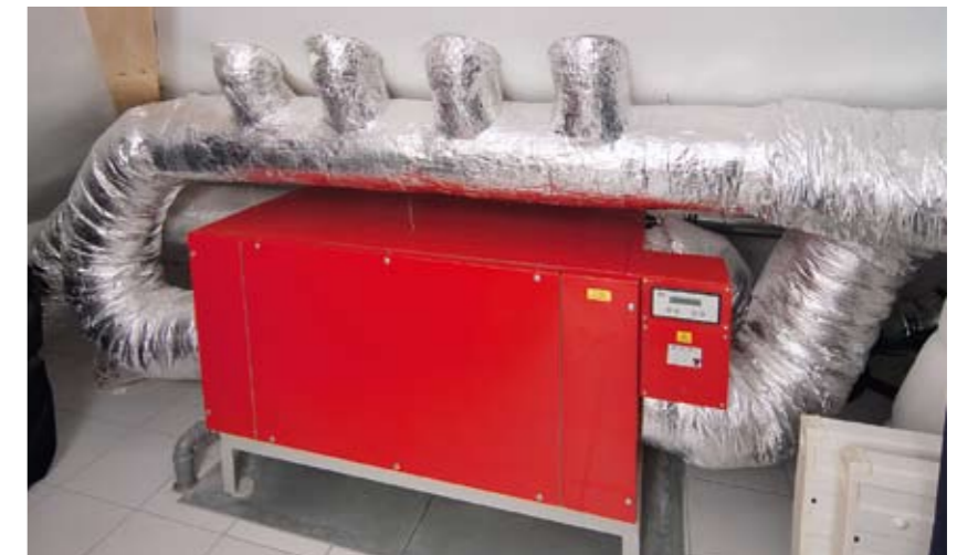
Ökologisch: Geheizt wird mit einer Luft/ Luft-Wärmepumpe. Die verbrauchte Luft erwärmt die hineinfließende
